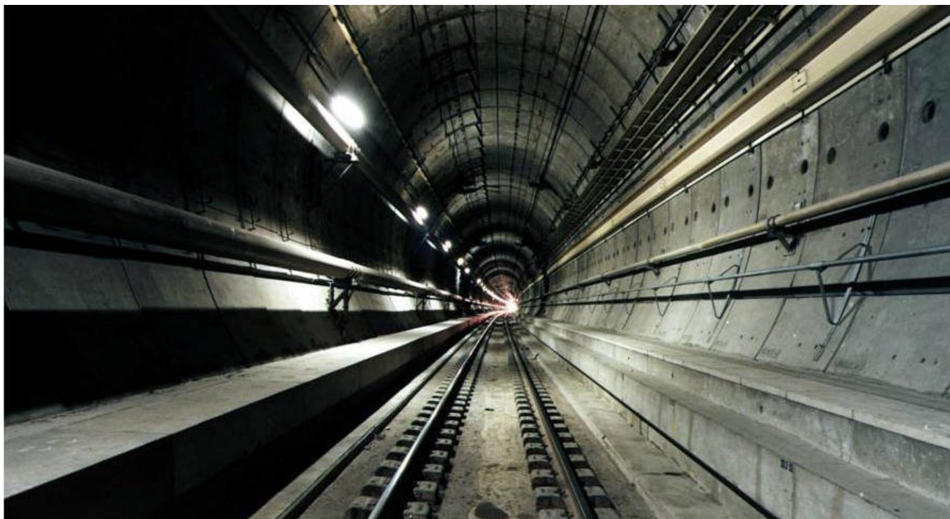
Vista interior de uno de los túneles de recorrido
